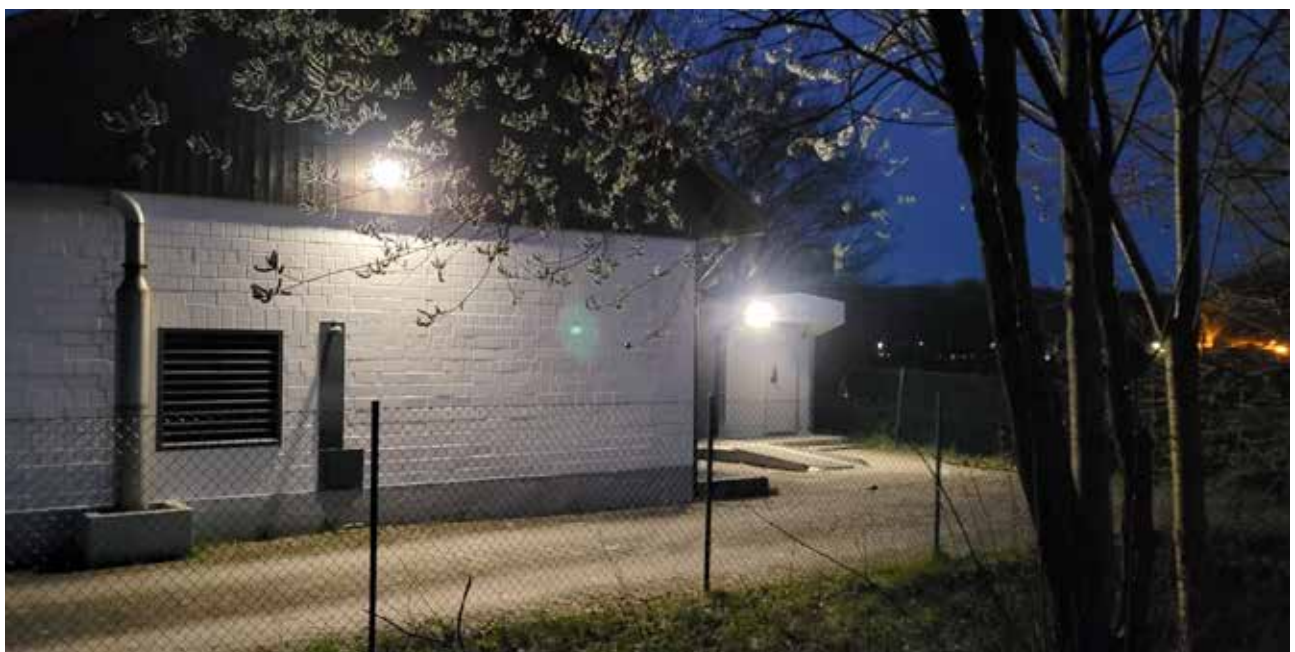
Neue Beleuchtung am Kelheimer Standort © Josef Feichtmeier
